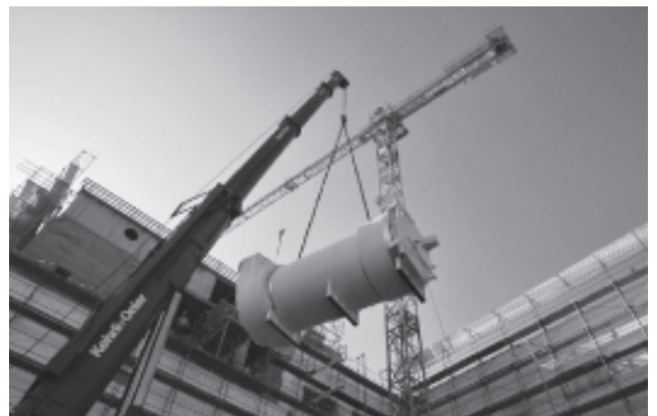
Einbringen des Lufterhitzers
