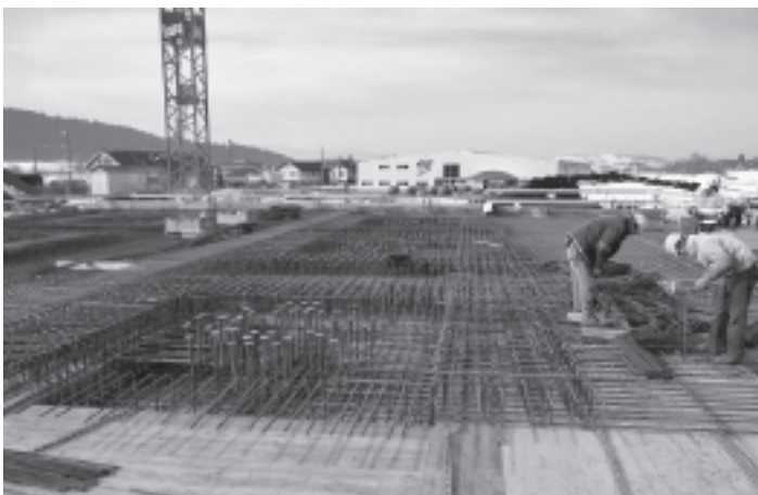
Verlegen der Armierungen
