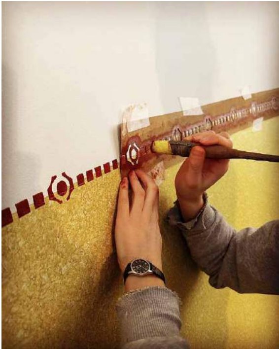
Treppenhaus, Langnau i.E.
