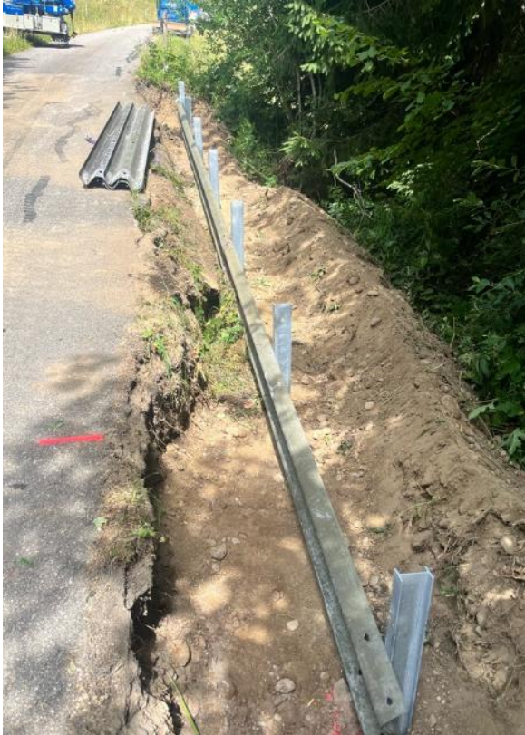
Abbildung 2: Beispiel Bankettsicherung mit Occasions-Planke Typ A.
