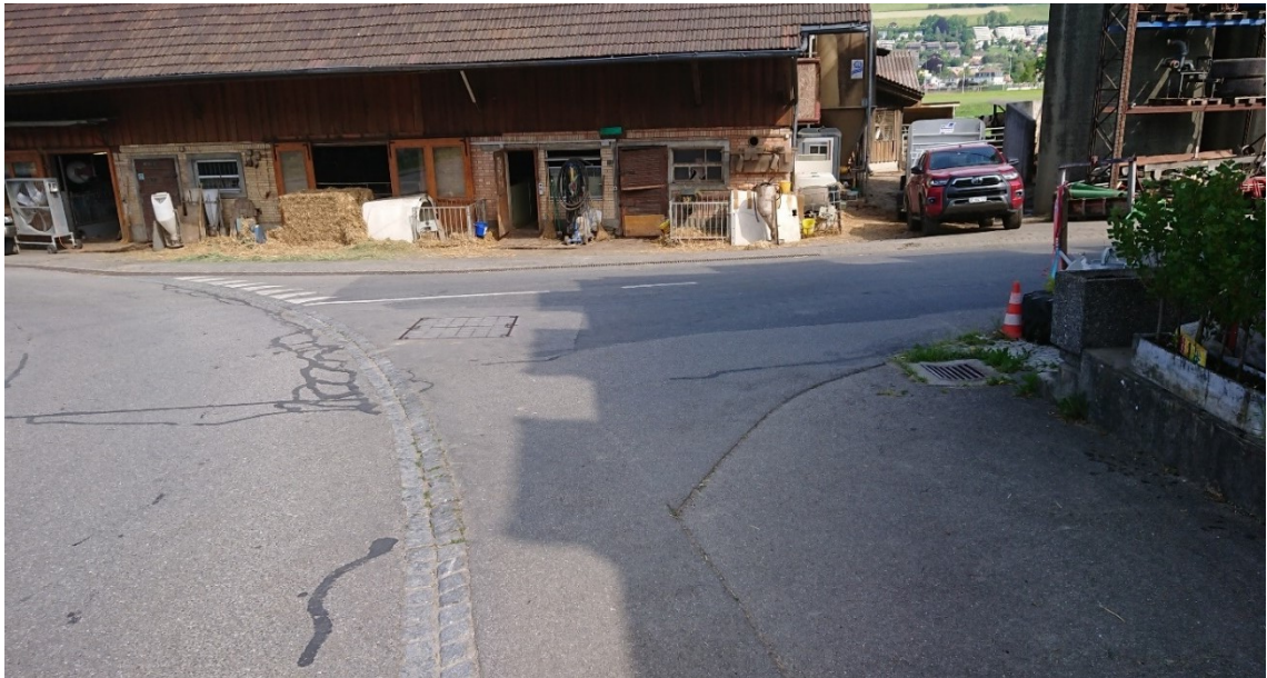
Abbildung 3 Fehlende Kennzeichnung des Strassenrands beim Einmündungstrichter des Katzengässlis in die Freimettigenstrasse
