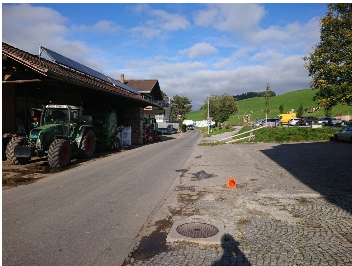
Abbildung 17 Strassenraum Katzengässli kurz vor dem Knoten Freimettigenstrasse/Katzengässli
