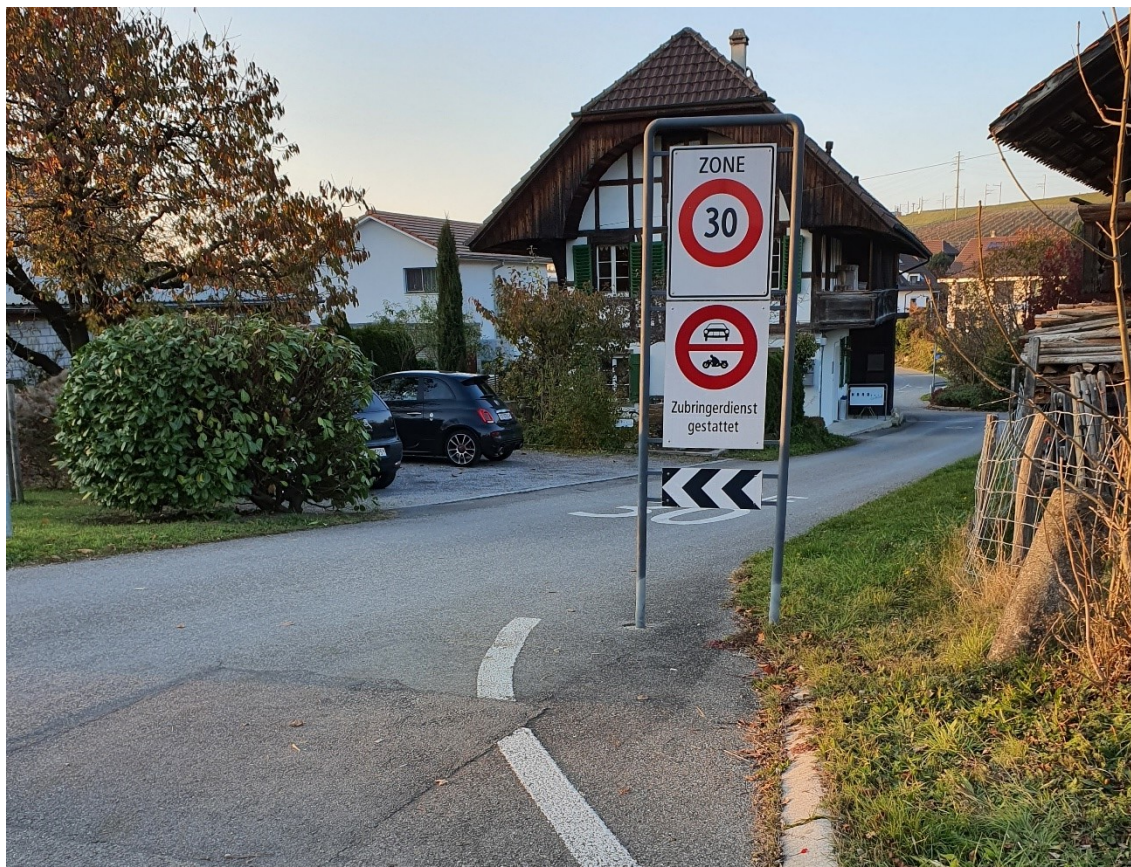
Abbildung 23 Beispiel Tor mit Zonensignalisation in Tägerschi
