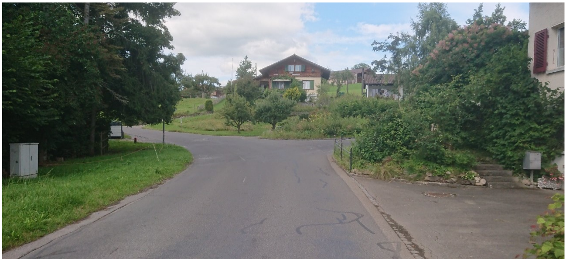
Abbildung 9 Knoten Bachsgraben mit ungenügender Sichtweite nach links
