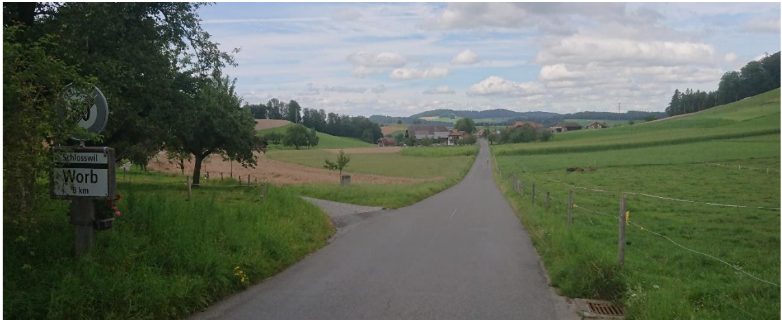
Abbildung 11 Geradliniger Strassenverlauf zwischen Nieder-Gysenstein und Gysenstein
