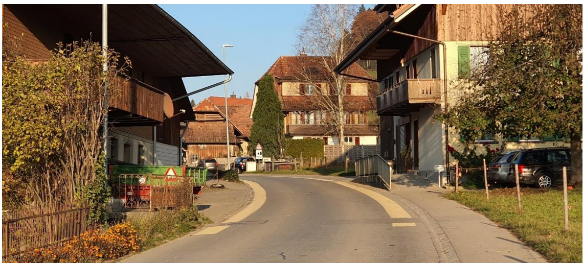
Abbildung 24 Beispiel beidseitige FGSO in Niederhünigen
