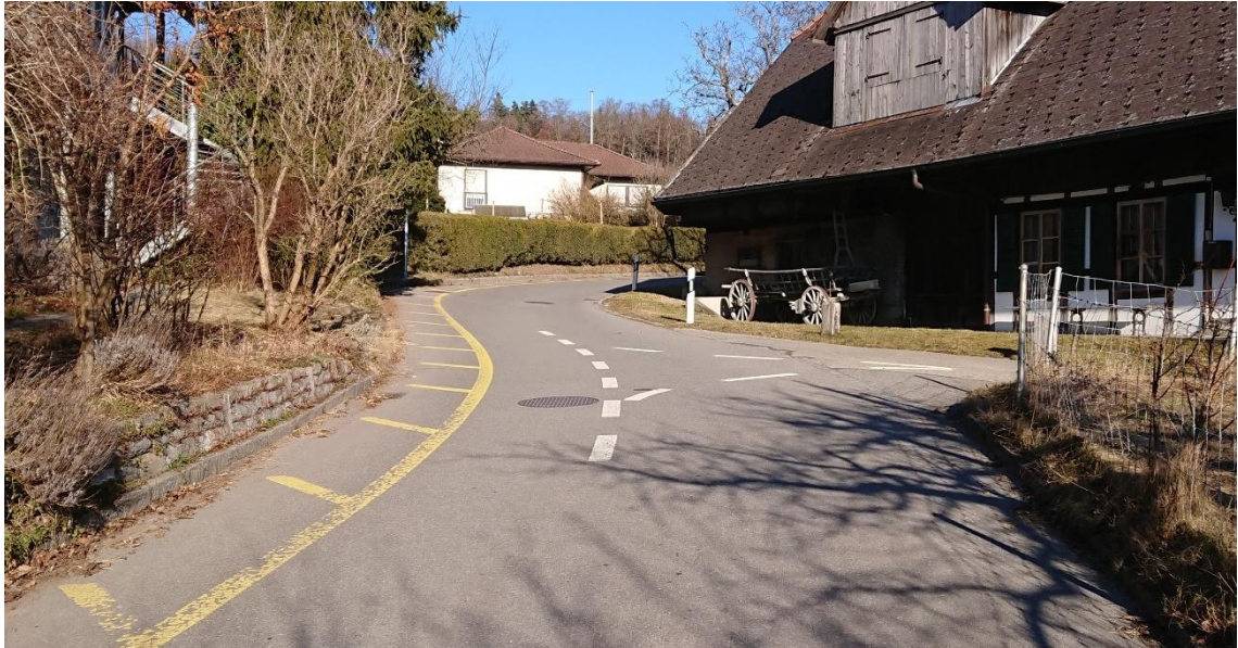
Abbildung 23 Beispiel Fussgängerlängsstreifen und Tulpenmarkierung in Vielbringen bei Worb (Strassenbreite ca. 5 m)
