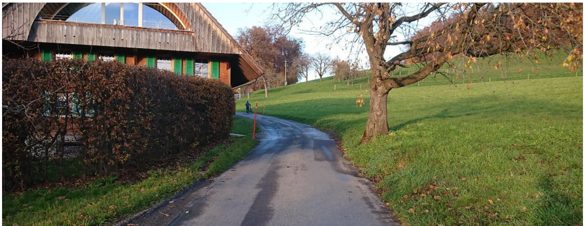
Abbildung 13 Ungenügende Anhaltesichtweite für 80 km/h in der Streusiedlung
