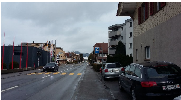
Abbildung 10: Fehlende Mittelinsel bei Fussgängerstreifen
